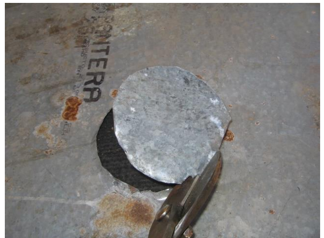
Figura 9. Corte agujero en la lámina metálica
