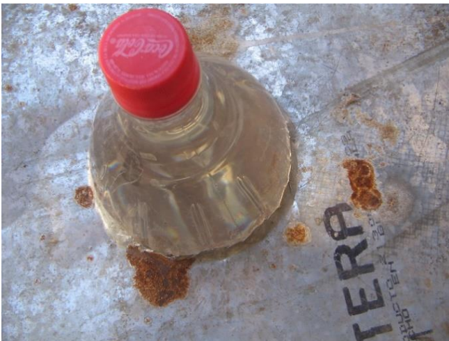
Figura 11. Colocación de la botella dentro del agujero
