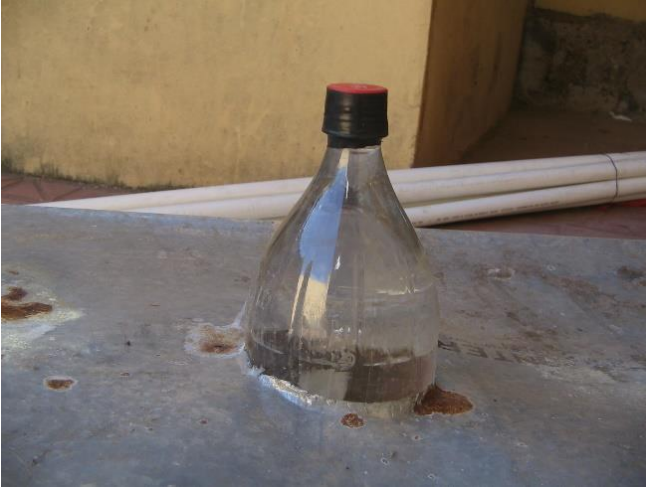
Figura 14. Sellar con cinta aislante la tapa y con tapagotas el punto de ensamble
