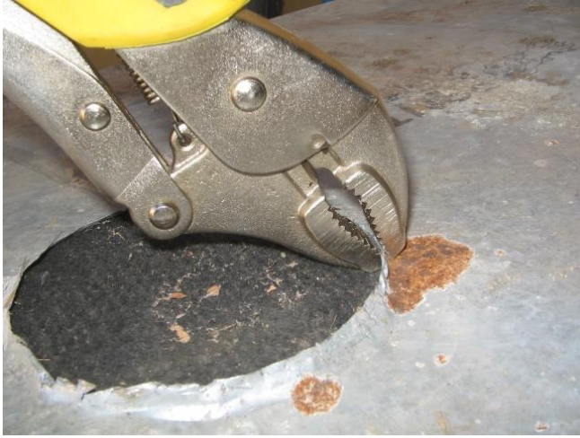
Figura 10. Hechura de pestaña de ajuste en el borde del agujero
