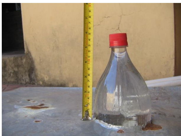
Figura 13. Parte de la lámpara que sobresale al exterior del techo
