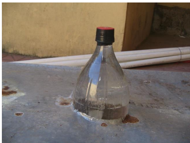
Figura 14. Sellar con cinta aislante la tapa y con tapagoteras el punto de ensamble
