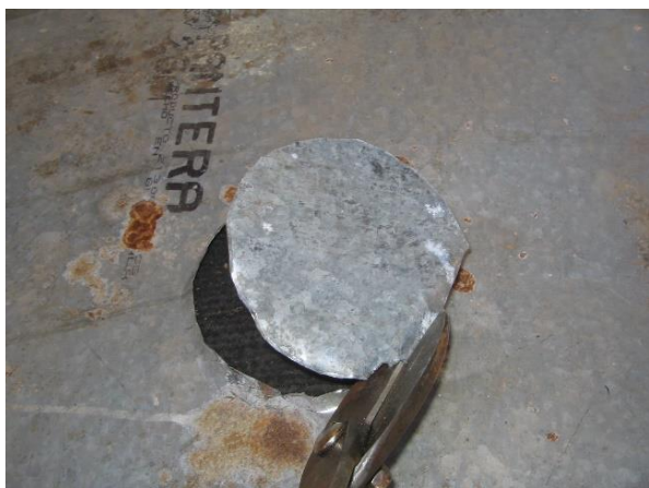
Figura 9. Corte agujero en la lámina metálica
