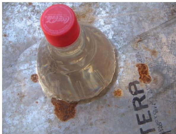
Figura 11. Colocación de la botella dentro del agujero
