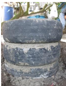
Repellado de la conexión de llantas.
