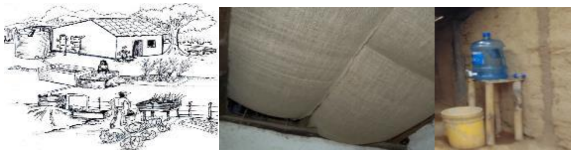
Casa Ecológica con mejoramiento de cielo falso con tejidos naturales y recipiente de agua con reutilización de materiales
