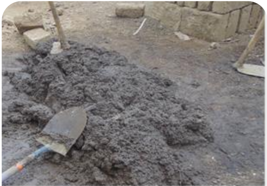
Figura 3. Mezcla de arena, arcilla y paja para hacer adobes
