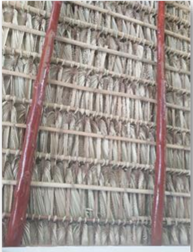
Figura 38. Techo de hojas de palmera y vigas de eucalipto
