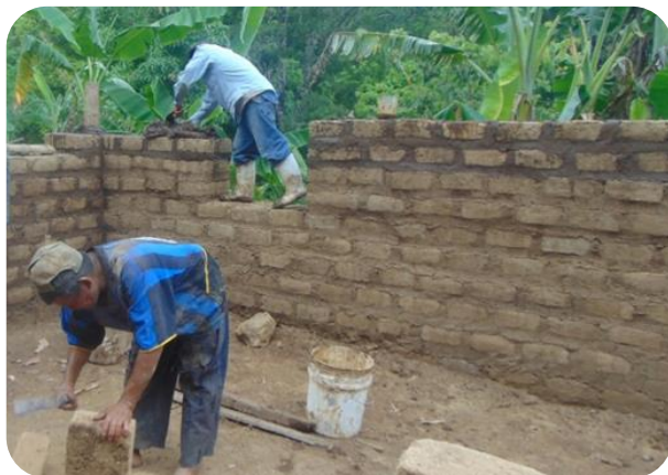
Figura 2. Construcción de una pared hecha con adobe
