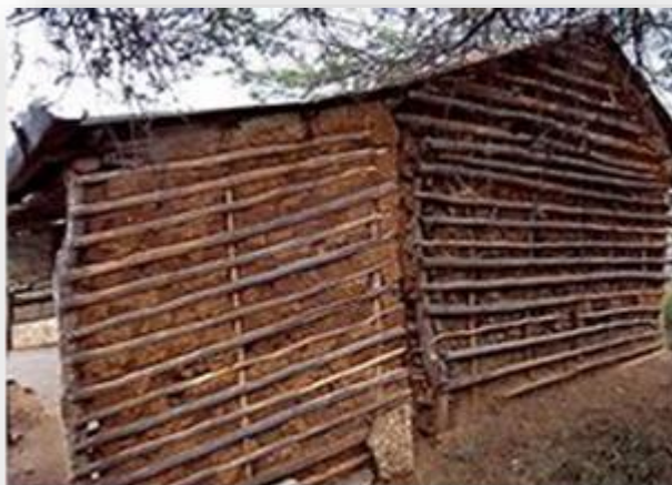
Figura 5. Pared de bahareque hecha de palos rollizos y lodo
