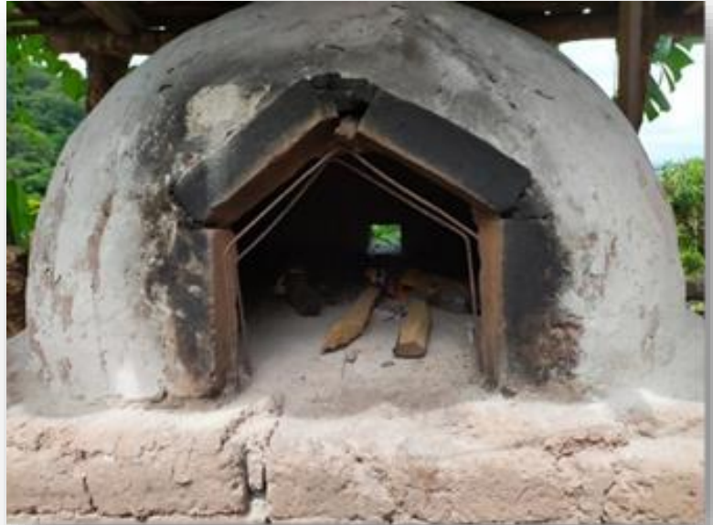
Figura 22. Horno de leña para elaborar pan hecho de barro crudo
