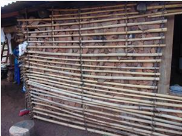
Figura 4. Pared de bahareque hecha de bambú y tejas quebradas
