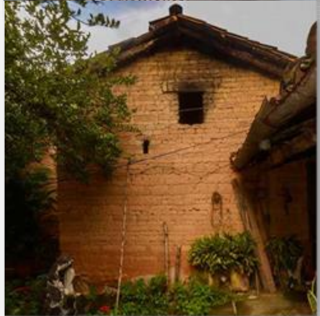
Figura 35. Tabanco de cocina y vista exterior de la ventana de aireación
